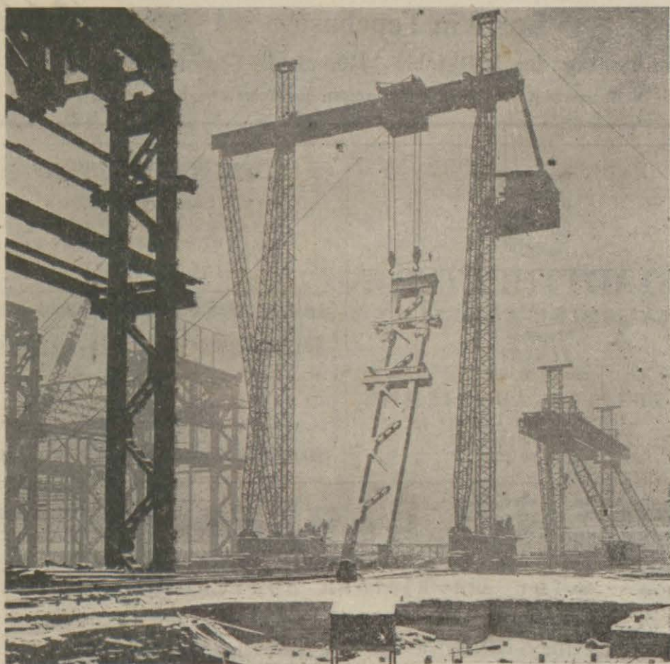
Stahlbau im strengsten Winter. Aufstellen einer 75 t schweren Säule bei 26° Kälte (Februar 1940)
